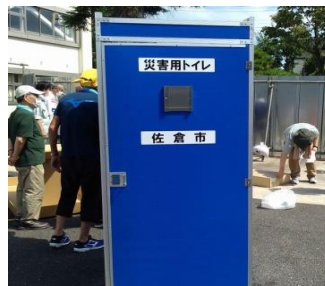
マンホールトイレ (外観)
